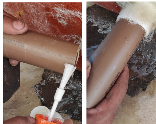
ADICIONAR COLA NAS SUPERFÍCIES DE COTANTO E ENCAIXAR O TUBO NA PEÇA
