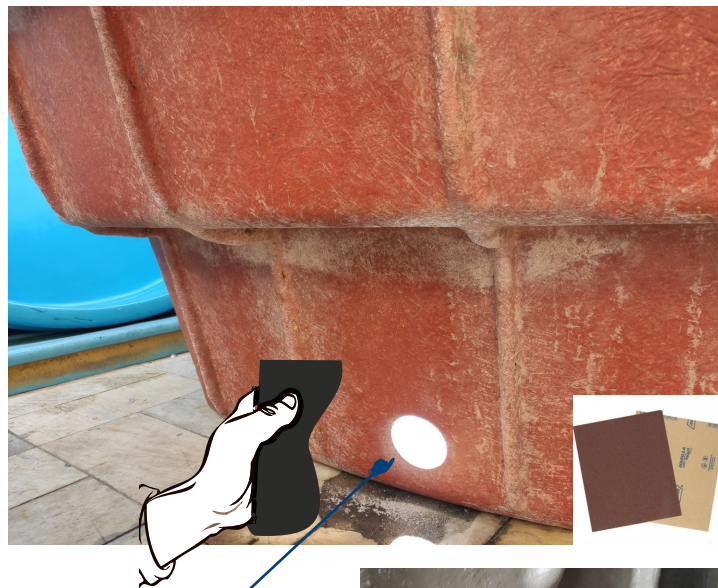
VISTA DO EXTERIOR DA PISCINA FURADA
