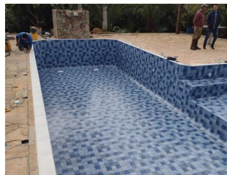
Em seguida é colocado um pouco de água para assentar o vinil no fundo e parede da piscina, enquanto isso é feito o flangeamento final de acessórios nas paredes, como skimmers, dispositivos hidráulicos de retorno e de iluminação.
