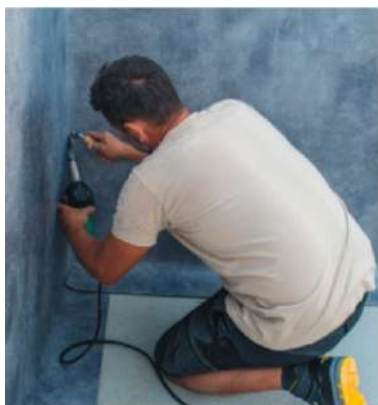
Solda do fechamento da parede
