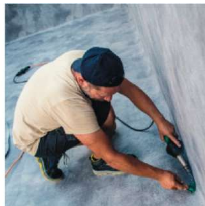
Solda fechamento da parede com o fundo
